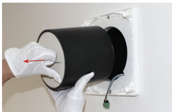
Herausziehen des Keramikwärmespeichers
